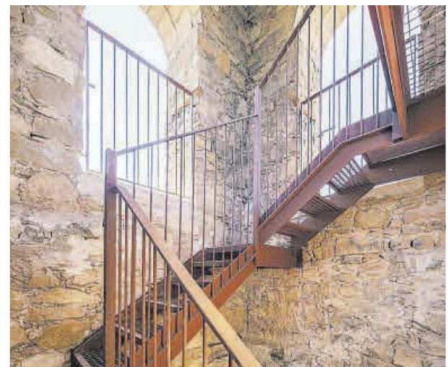
Escala metàl·lica que puja fins a la part més alta del campanar
