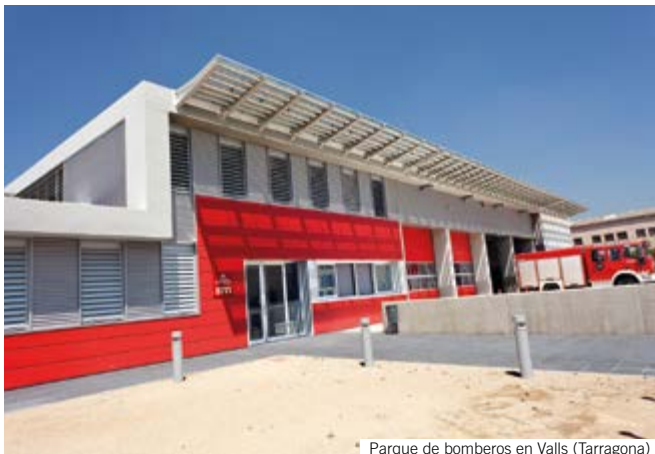
Parque de bomberos en Valls (Tarragona)
