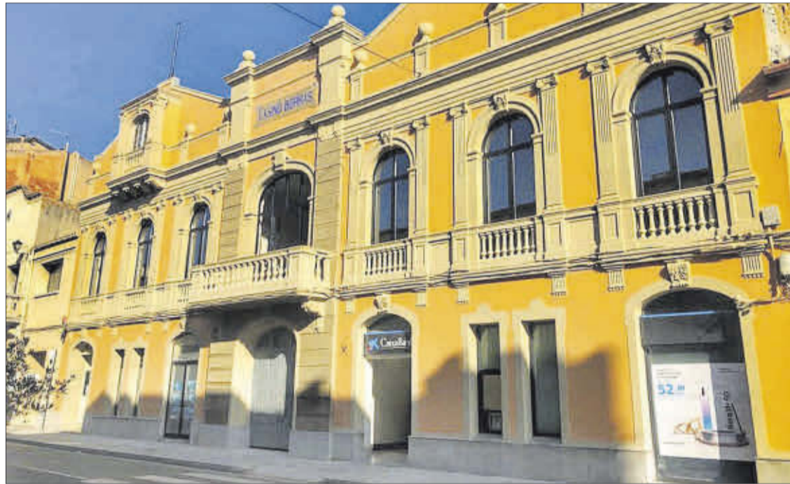
Una imatge de la façana del Casino Borràs, acabada de restaurar fa uns mesos
