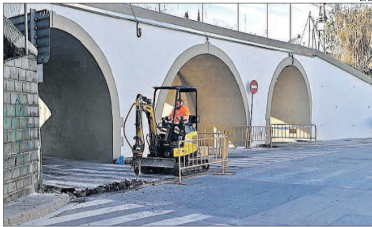
Les obres sota el pont de Ferrocarrils han començat aquesta setmana
