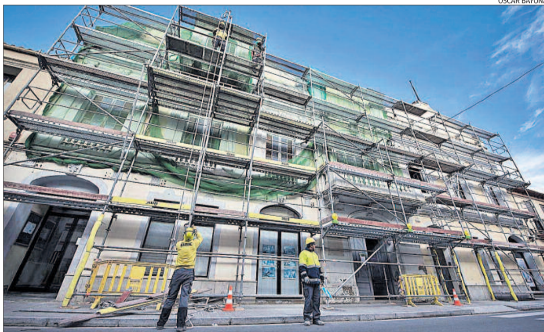
Una gran bastida ja cobreix la façana perquè es puguin fer els treballs de rehabilitació
