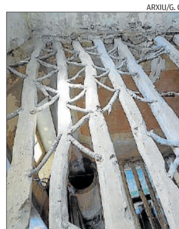
El forjat inèdit a l'antiga fonda
