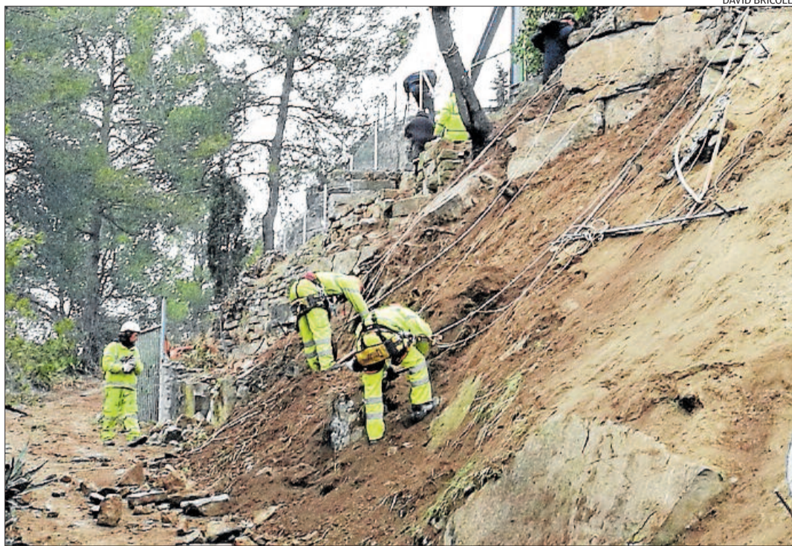
Operaris treballant a la paret del turó que s'ha de fixar i que ara s'ha netejat de vegetació i roques
