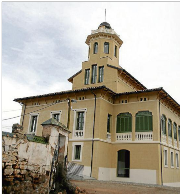
Exterior de la torre Lluvià, al camí de Rajadell
