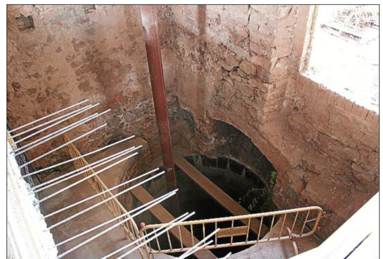
Forat de la tina de tres metres de diàmetre, que deixaran a la vista
