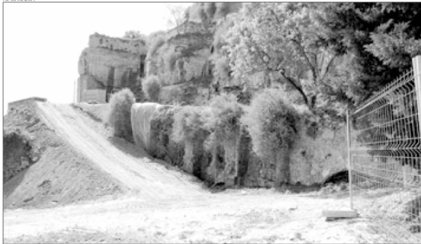
Treballs previs a les obres de recuperació del Camí dels Corralles, a sota la Seu
