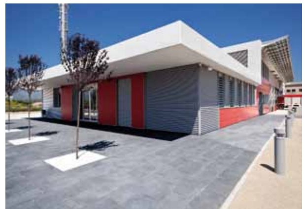
Un pliegue de la cubierta de hormigón resuelve la diferencia de alturas
