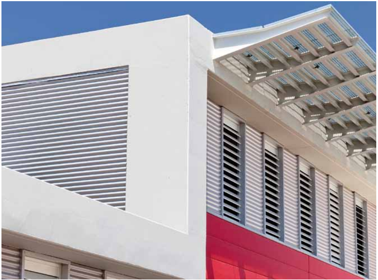
La cubierta del edificio sobresale creando un voladizo de hormigón en todo el perímetro del edificio
