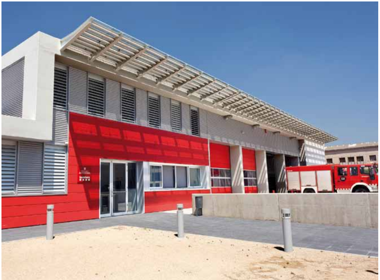
El nuevo parque de bomberos tiene doble altura en la parte de las cocheras, en la parte central del edificio y en el extremo sur de la planta baja
