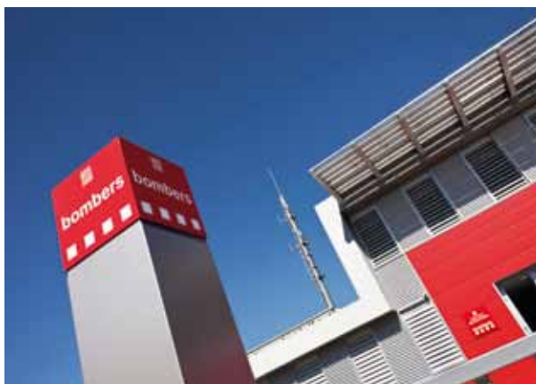
El rojo de los paneles sándwich y el gris definen la fachada
