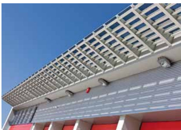
La chapa ondulada resigue el canto interior de la cubierta
