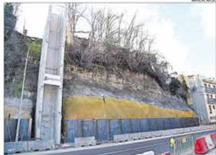
Les obres del nou ascensor, aquesta setmana, amb la torre construïda
