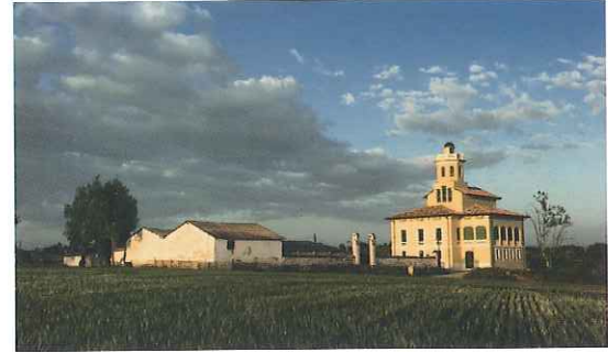
Rehabilitación Torre Lluvià, Manresa. Fotografía: Francesc Rubi
