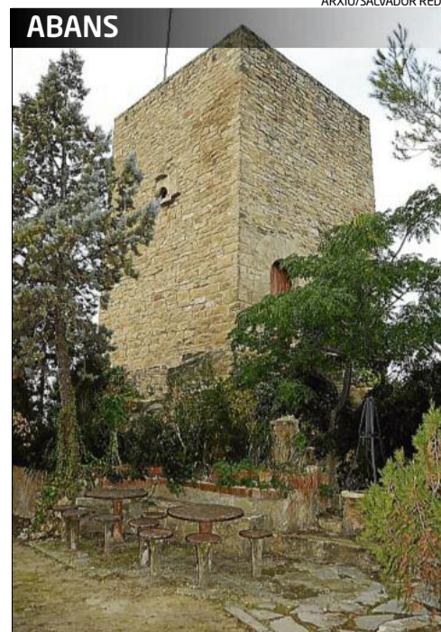
Abans de l'enderroc, la base quedava oculta
