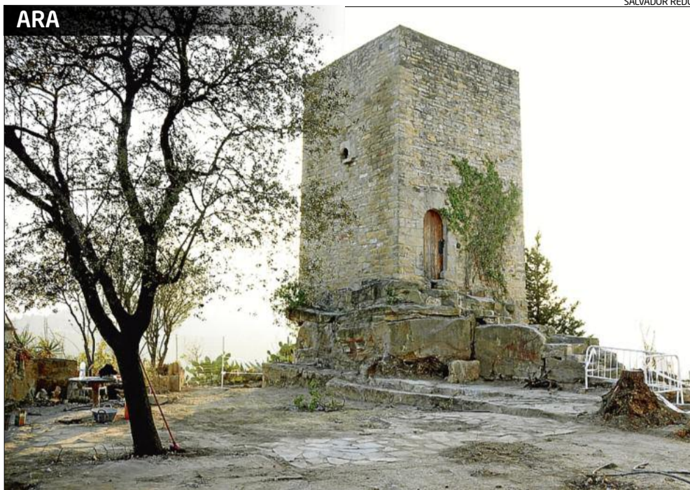
Després de l'enderroc i la neteja, la torre medieval és visible des de la base
