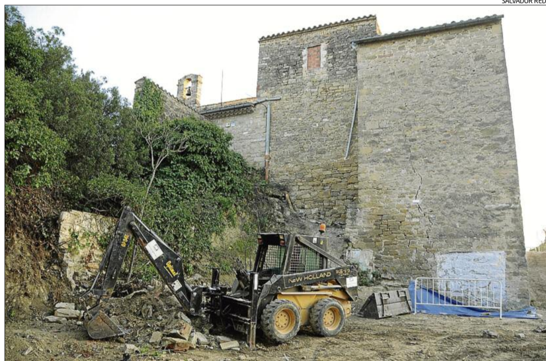
Una màquina treballant en la retirada de les darreres runes, a la part posterior de l'ermita i la masoveria
